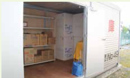
▲防災備蓄倉庫の開放・点検
