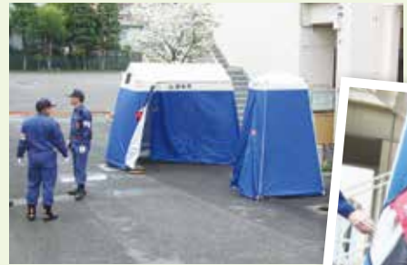
▲マンホールトイレ設営
